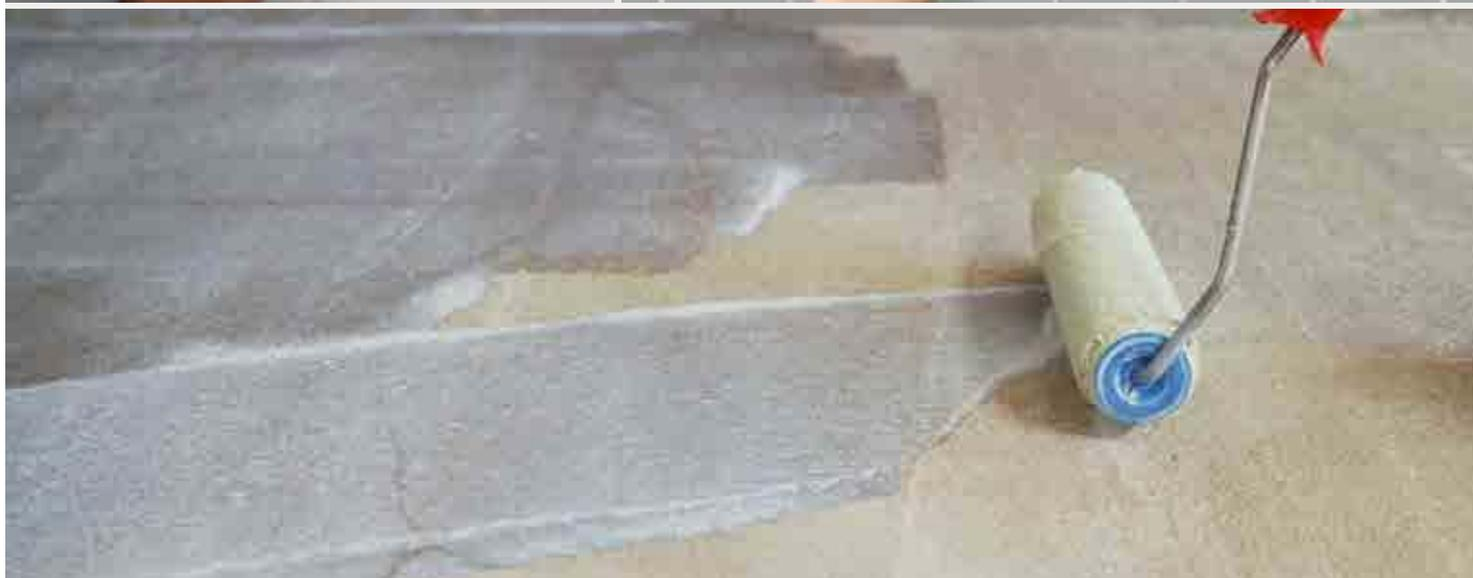
Dopo almeno 6 ore dalla stesura del primer, applicare il TASSOFLOOR TOUCH a grana grossa con una spatola di acciaio o di plastica, con l'accortezza di stendere un velo abbastanza sottile (quantità eccessive di prodotto steso in un'unica passata potrebbero creare fessurazioni dopo l'asciugatura).
